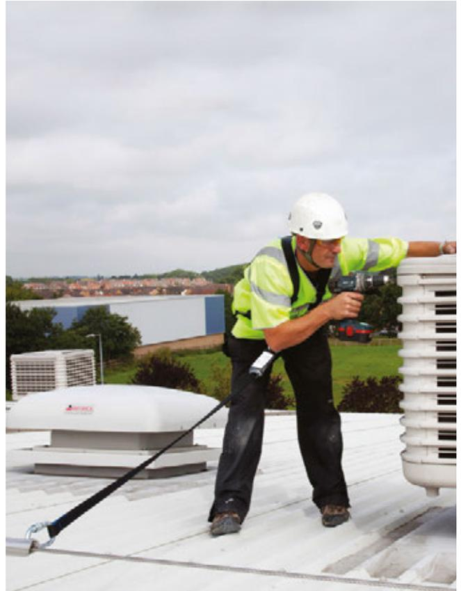
Das horizontale Sicherungssystem Safeline besteht aus einem gespannten Drahtseil, in das ein mobiler Seilläufer eingehängt wird. Über diesen Seilläufer wird der Nutzer mit dem System verbunden. Safeline-Systeme schützen nicht nur die Arbeiter in der Höhe, sie bieten auch den Schutz im Verantwortungsbereich des Unternehmens.
