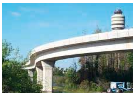
Eine typische Straßenbrücke aus vorgegossenem Beton
