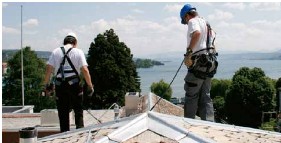
Ein typisches System, das zur Gebäudewartung installiert wurde
