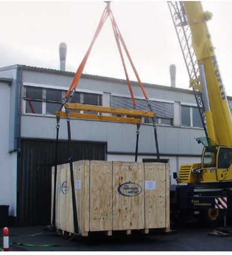
Spreiztraversen-Gehänge Anschlag unterhalb des Lastschwerpunktes
